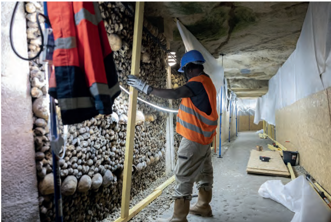
Installation des protections des murs d'ossements © Paris Musées
