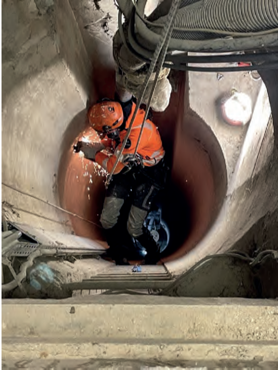
Puits d'accès au souterrain destiné à l'acheminement des matériaux du chantier © Paris Musées
